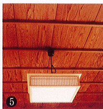
和室1:次間(二之間)の天井
