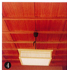
和室1:主座敷(一之間)の天井
