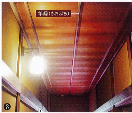
和室1:北側トイレまでの天井
