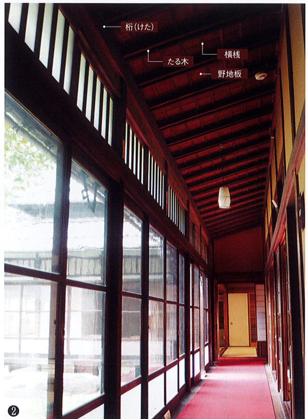
和室2:南側の入側天井
