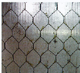
押開窓 型板ガラス（西蔵地下室）
