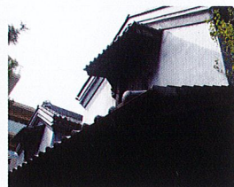
右：煉瓦造・黒漆喰仕上げ（東蔵） 左：木造・黒漆喰仕上げ（西蔵）
