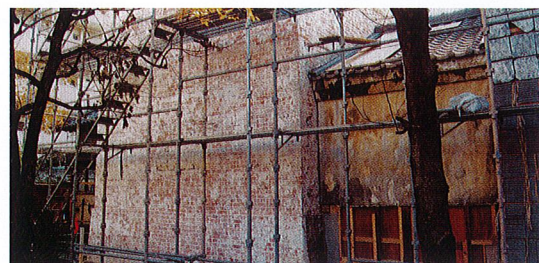
平成20年度の蔵の修理工事 黒漆喰仕上げの下地の煉瓦（東蔵）と平瓦（西蔵）
